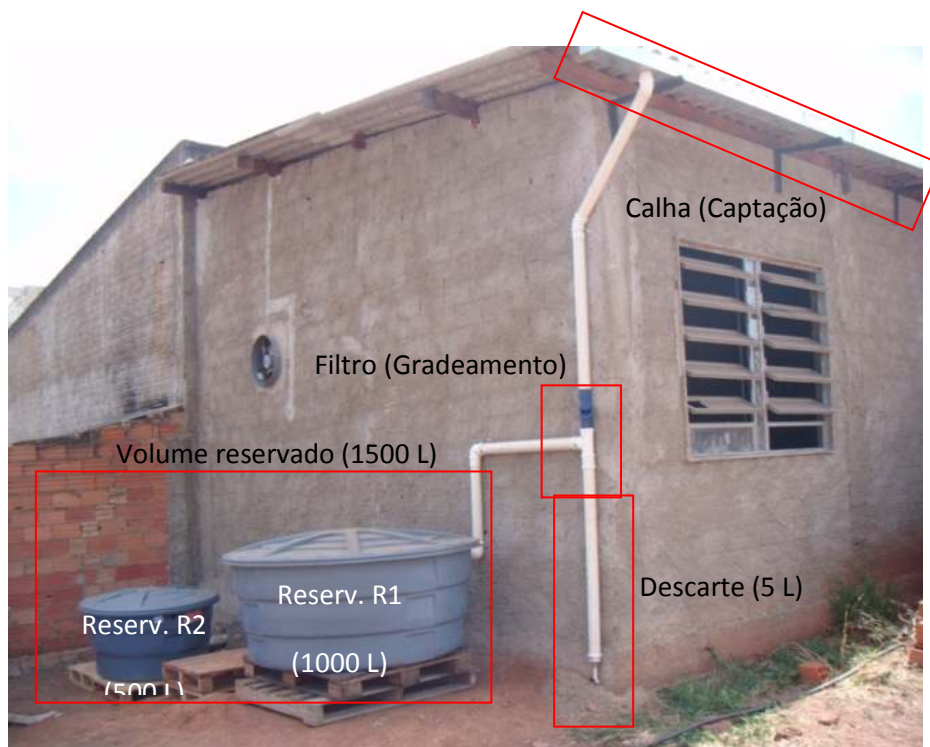
Figura 4 – Montagem do sistema de aproveitamento de águas pluviais com suas etapas
