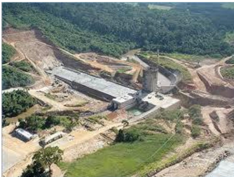
Figura 2. Vista área da barragem em construção na Bacia do Ribeirão João Leite. Fonte: SANEAGO de Goiás S/A.
