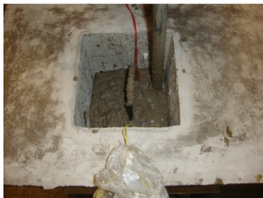
e) Concretagem do primeiro nicho.
