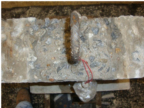
c) Superfície rugosa na interface com o concreto dos nichos
