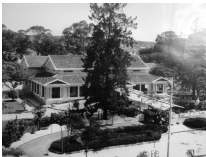
Figura1: Antiga sede do Jóquei Clube de Goiás, Autor desconhecido. Fonte: Arquivo do Jóquei Clube de Goiás, Goiânia, 2011.
