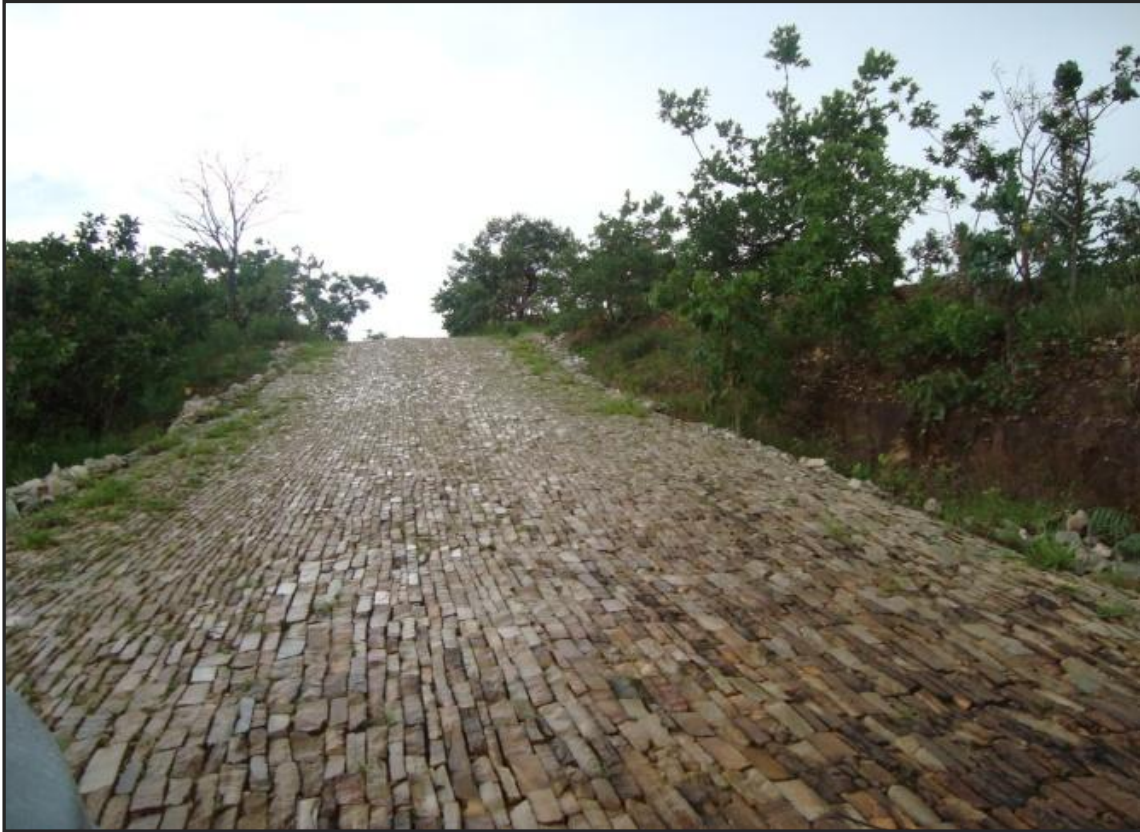
Imagem 02: Estrada revitalizada utilizando rejeitos de Quartzito no acesso a Reserva Ecológica Vargem Grande.
