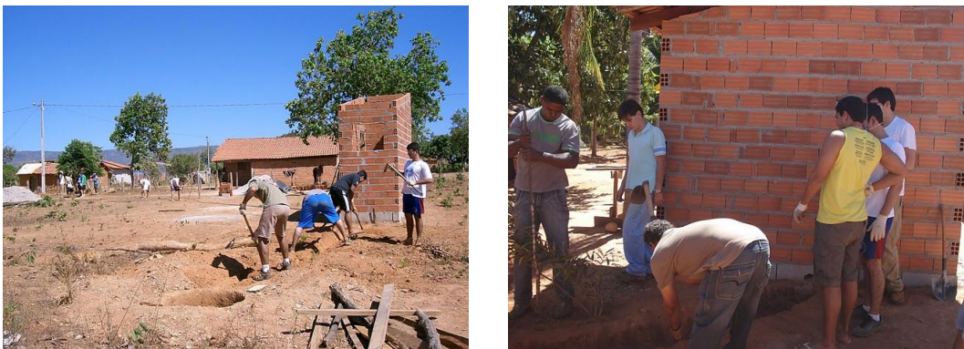
Figura 2. Construção dos banheiros na comunidade de Campo Alegre (TO).
