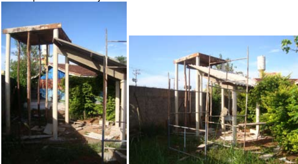
Imagens da estrutura onde ficará o coletor solar de baixo custo
