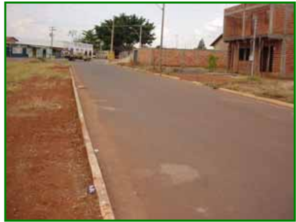
Figura 1 – Pavimento executado com entulho na rua SR-68, Setor Recanto das Minas Gerais, Goiânia-GO: (a) Camadas; (b) Vista geral (Set/2006).
