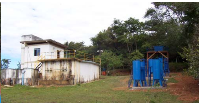
Figura 2- Vista da ETA em Goianópolis em paralelo com a FiME
